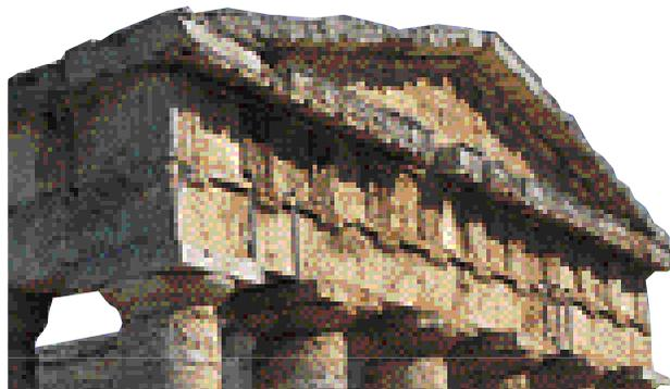
Los **dinteles** soportan esfuerzos de flexión. Se colocan horizontalmente y se apoyan sobre las columnas. Sirven para sujetar las cubiertas.
