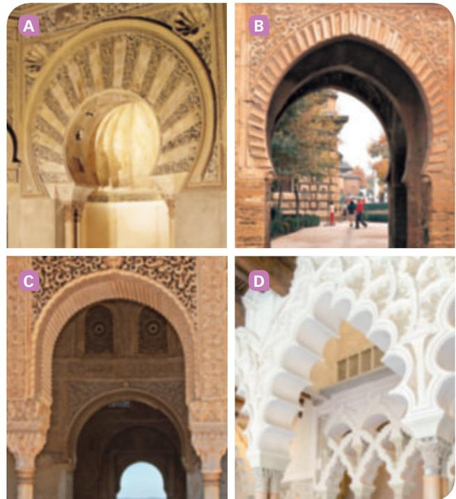
19. Arco de herradura. (A) Arco de herradura apuntado. (B) Arco de medio punto. (C) Arco lobulado. (D)
