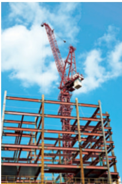
Estructura fabricada amb perfils.
