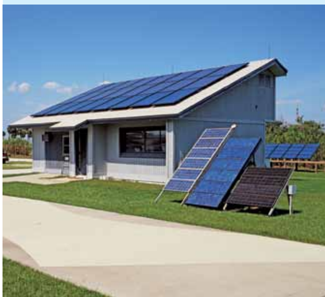
Paneles de energía solar.
