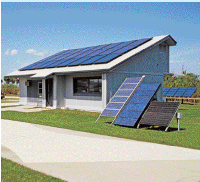
Paneles de energía solar.
